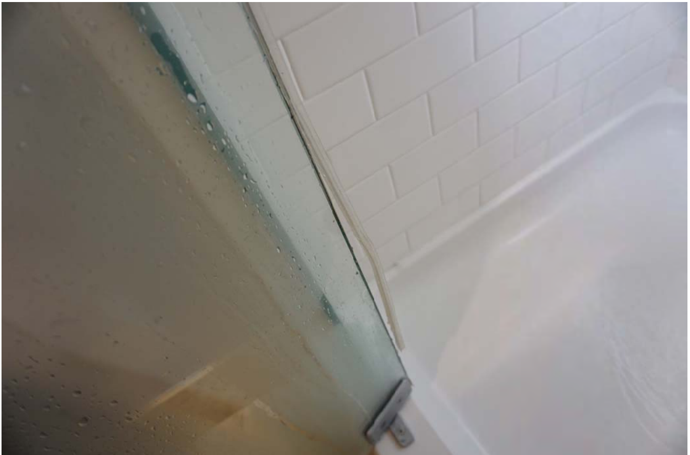
14) Loose door weather stripping
