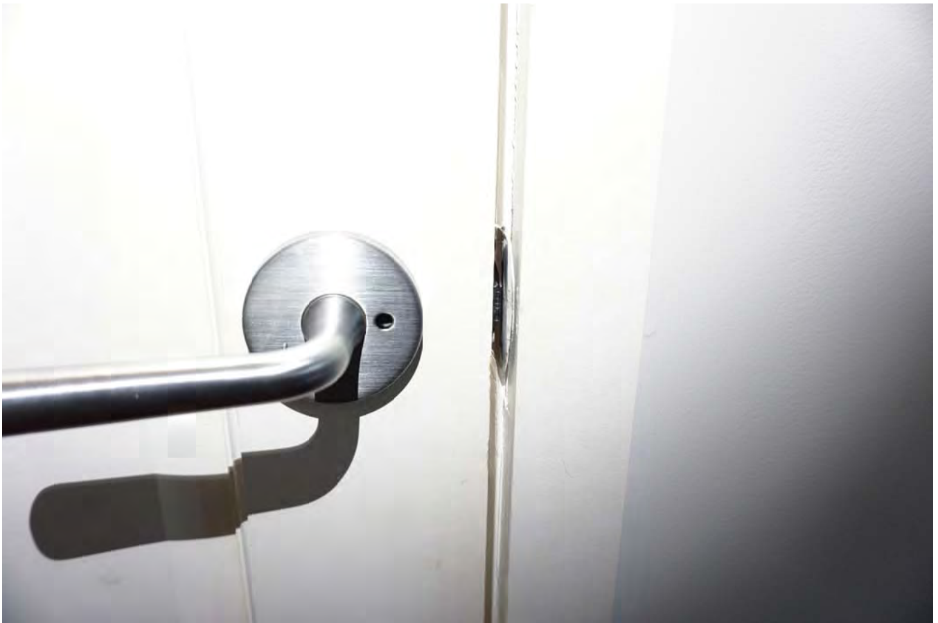
23) Door lock handle missing
